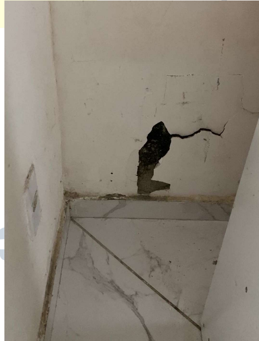
Fotos 22 e 23: Desagregamento do revestimento em pintura com massa corrida, causado por umidade ascensional. Proliferação de fungos. Foi aplicado impermeabilizante com base asfáltica sobre o revestimento argamassado. Quarto 2. Fonte: Perito
