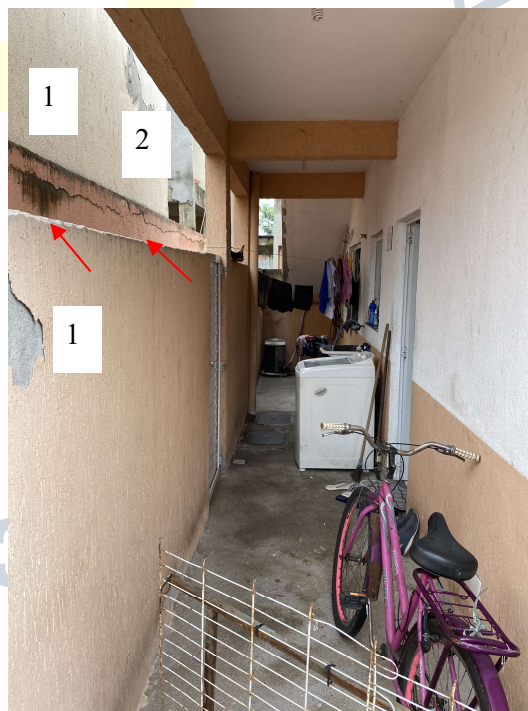
Fotos 6 e 7: Entrada de acesso ao imóvel e área de serviços [1] Fissuras de higroscópicas, pela ausência de capa de muro; [2] Proliferação de fungos; [3] desagregamento proveniente de umidade, pela ausência de capa de muro.
