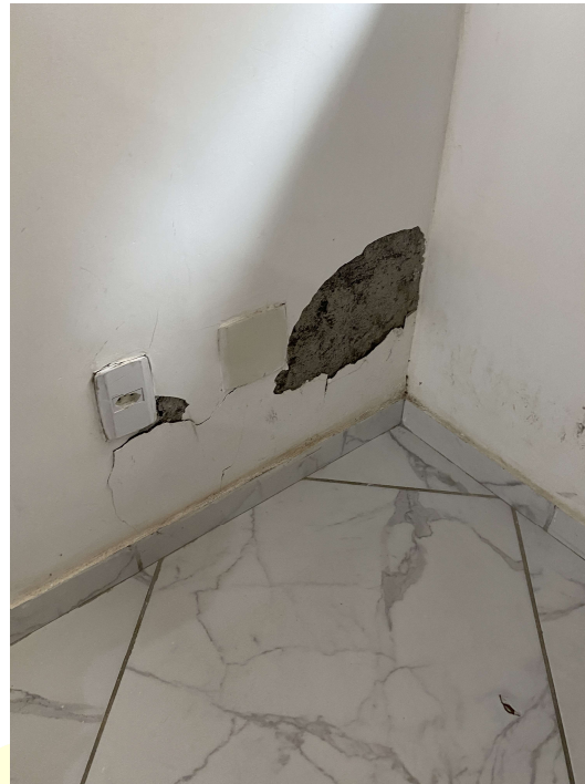
Fotos 20 e 21: Desagregamento do revestimento em pintura com massa corrida, causado por umidade ascensional. Proliferação de fungos. Foi aplicado impermeabilizante com base asfáltica sobre o revestimento argamassado. Quarto 2. Fonte: Perito
