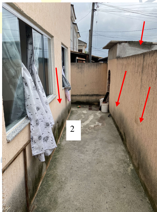
Fotos 26 e 27: [1] Desagregamento do revestimento em textura, causado por umidade ascensional. Proliferação de fungos. [2] Ausência de capa de muro. Área externa. Fonte: Perito
