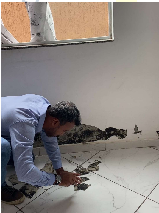
Fotos 14 e 15: Verificação sendo efetuada pelo Perito. Foi aplicado impermeabilizante com base asfáltica sobre o revestimento argamassado. O revestimento argamassado encontra-se pulverulento e enfraquecido, causado pela umidade ascensional. Fonte: Perito
