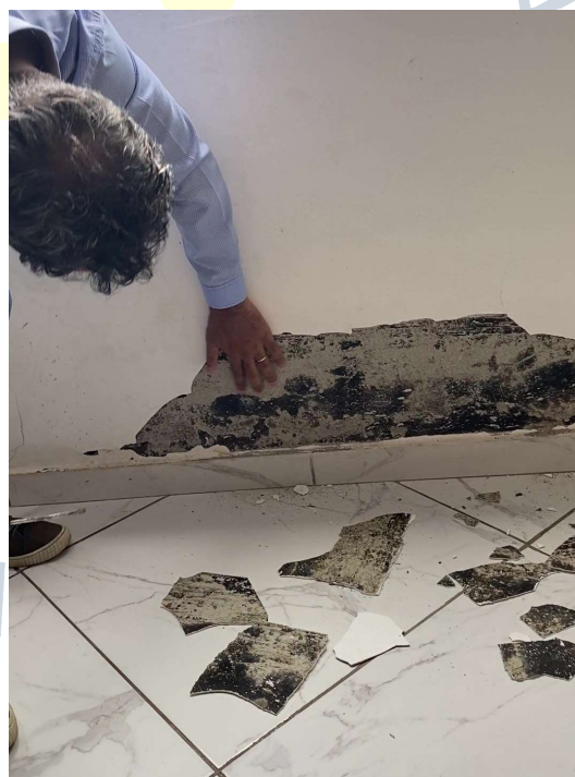
Fotos 14 e 15: Verificação sendo efetuada pelo Perito. Foi aplicado impermeabilizante com base asfáltica sobre o revestimento argamassado. O revestimento argamassado encontra-se pulverulento e enfraquecido, causado pela umidade ascensional. Fonte: Perito
