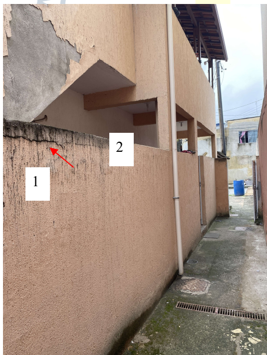
Fotos 6 e 7: Entrada de acesso ao imóvel e área de serviços [1] Fissuras de higroscópicas, pela ausência de capa de muro; [2] Proliferação de fungos; [3] desagregamento proveniente de umidade, pela ausência de capa de muro.
