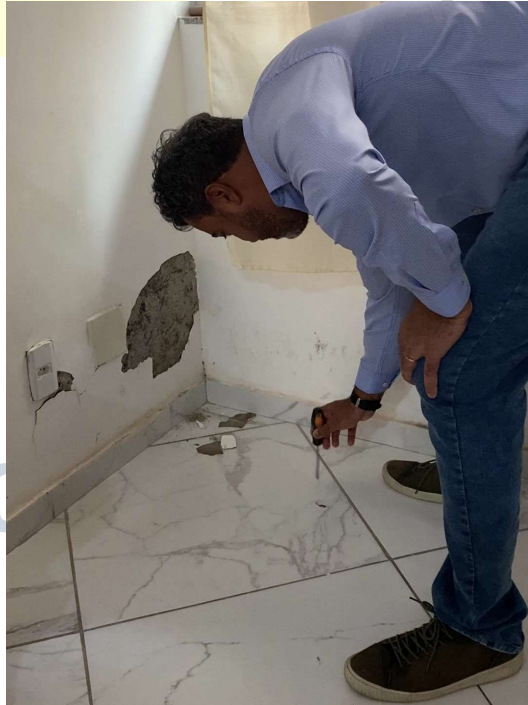
Fotos 10 e 11: Ensaio percussivo. Revestimento cerâmico apresentando som cavo (oco), anomalia na aderência. Sala de estar. Fonte: Perito
