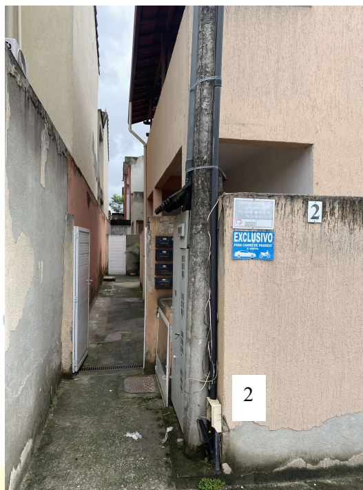
Fotos 4 e 5: Fachada e acesso do imóvel. [1] Proliferação de fungos, pela ausência de capa de muro; [2] descascamento proveniente de umidade.
