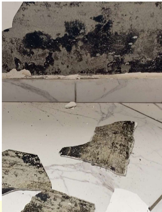
Fotos 8 e 9: Desagregamento do revestimento em pintura com massa corrida, causado por umidade ascensional. Proliferação de fungos. Foi aplicado impermeabilizante com base asfáltica sobre o revestimento argamassado. Sala de Estar. Fonte: Perito
