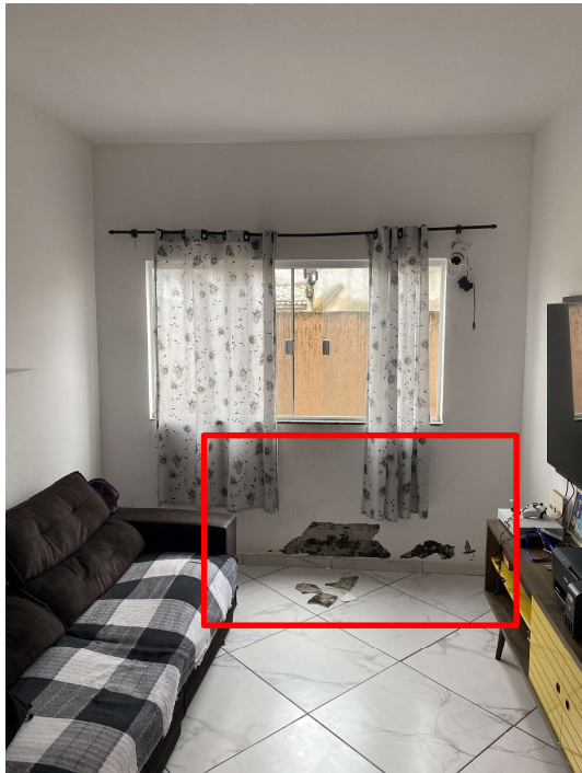
Fotos 8 e 9: Desagregamento do revestimento em pintura com massa corrida, causado por umidade ascensional. Proliferação de fungos. Foi aplicado impermeabilizante com base asfáltica sobre o revestimento argamassado. Sala de Estar. Fonte: Perito
