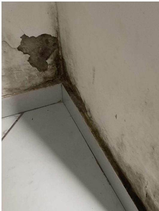
Fotos 20 e 21: Desagregamento do revestimento em pintura com massa corrida, causado por umidade ascensional. Proliferação de fungos. Foi aplicado impermeabilizante com base asfáltica sobre o revestimento argamassado. Quarto 2. Fonte: Perito
