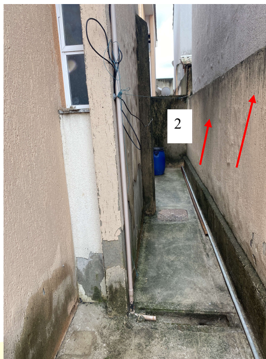
Fotos 24 e 25: [1] Desagregamento do revestimento em textura, causado por umidade ascensional. [2] Proliferação de fungos. Área externa. Fonte: Perito
