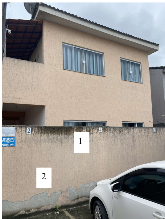
Fotos 4 e 5: Fachada e acesso do imóvel. [1] Proliferação de fungos, pela ausência de capa de muro; [2] descascamento proveniente de umidade.
