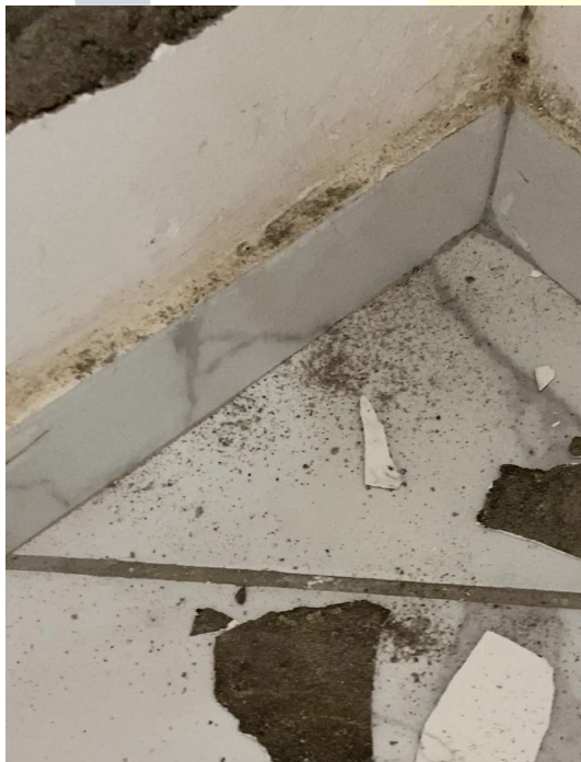
Fotos 22 e 23: Desagregamento do revestimento em pintura com massa corrida, causado por umidade ascensional. Proliferação de fungos. Foi aplicado impermeabilizante com base asfáltica sobre o revestimento argamassado. Quarto 2. Fonte: Perito
