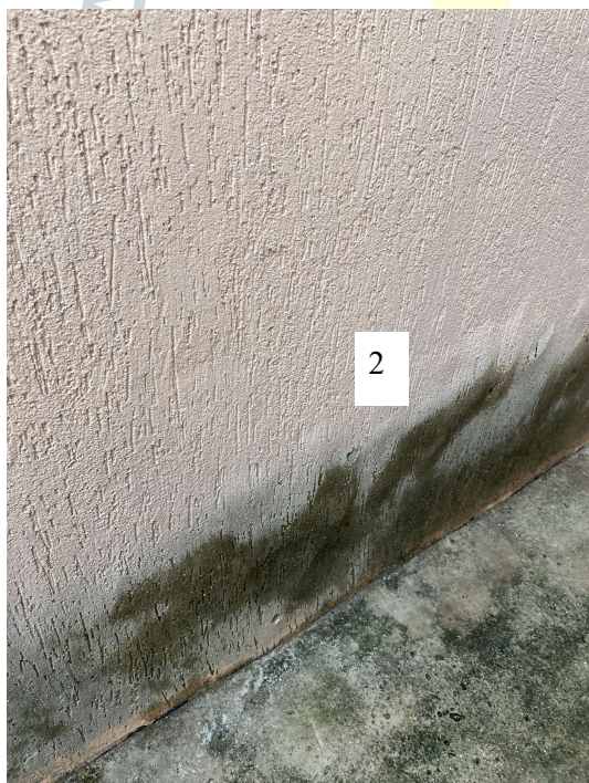
Fotos 26 e 27: [1] Desagregamento do revestimento em textura, causado por umidade ascensional. Proliferação de fungos. [2] Ausência de capa de muro. Área externa. Fonte: Perito
