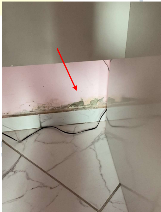
Fotos 18 e 19: Desagregamento do revestimento em pintura com massa corrida, causado por umidade ascensional. Proliferação de fungos. Quarto 1. Fonte: Perito
