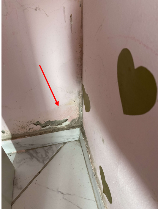
Fotos 18 e 19: Desagregamento do revestimento em pintura com massa corrida, causado por umidade ascensional. Proliferação de fungos. Quarto 1. Fonte: Perito
