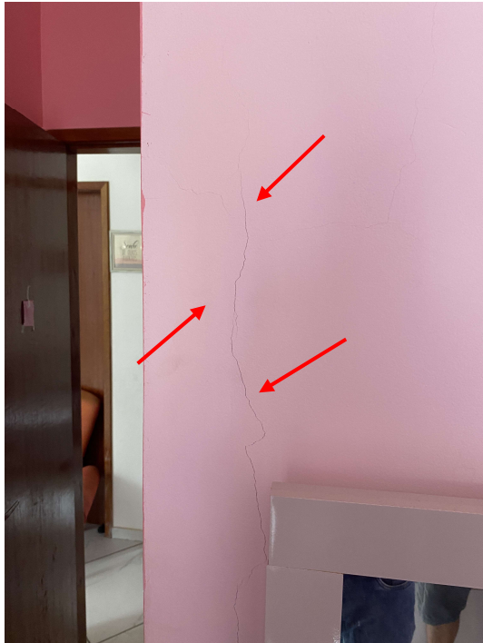
Fotos 16 e 17: Fissura não estrutural, causa provável falha na amarração da alvenaria. Quarto 1. Fonte: Perito
